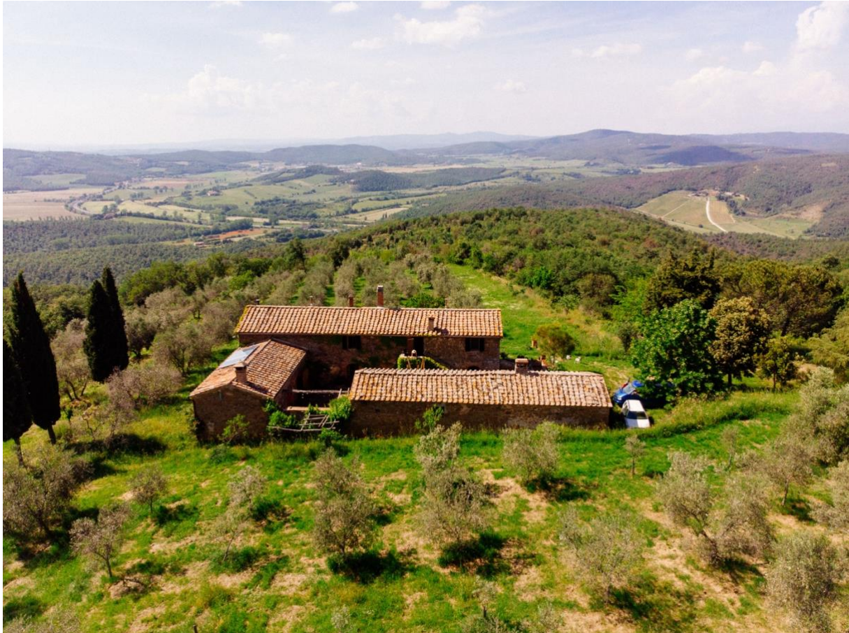
Podere Le Capanne
